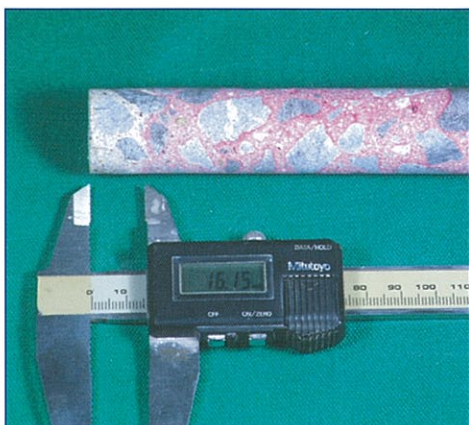
中性化深さの測定状況
