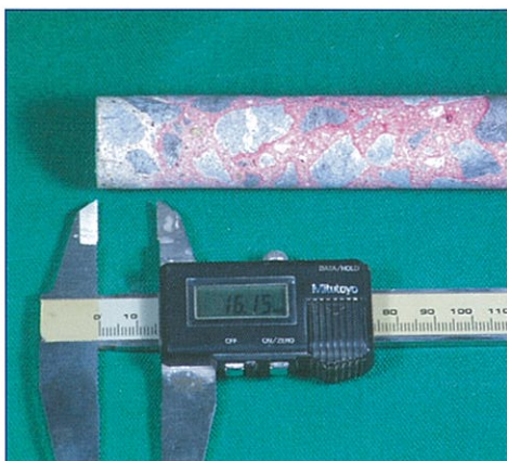
中性化深さの測定状況
